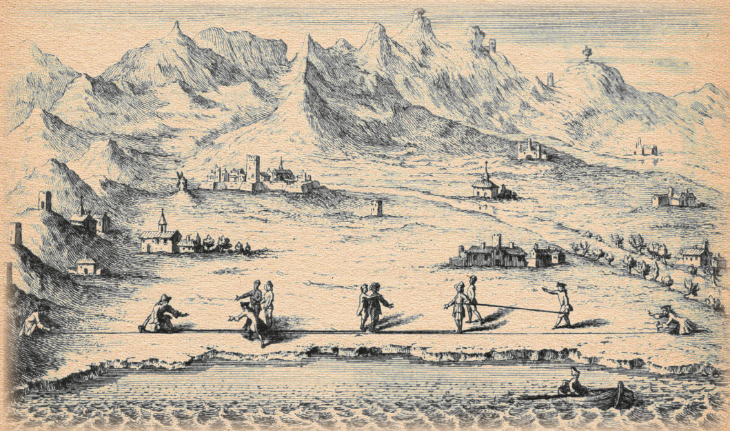
Mesure d'une base de triangulation dans la plaine de la Crau d'Arles au moyen de règles de bois de 2 toises (3,9 m).
