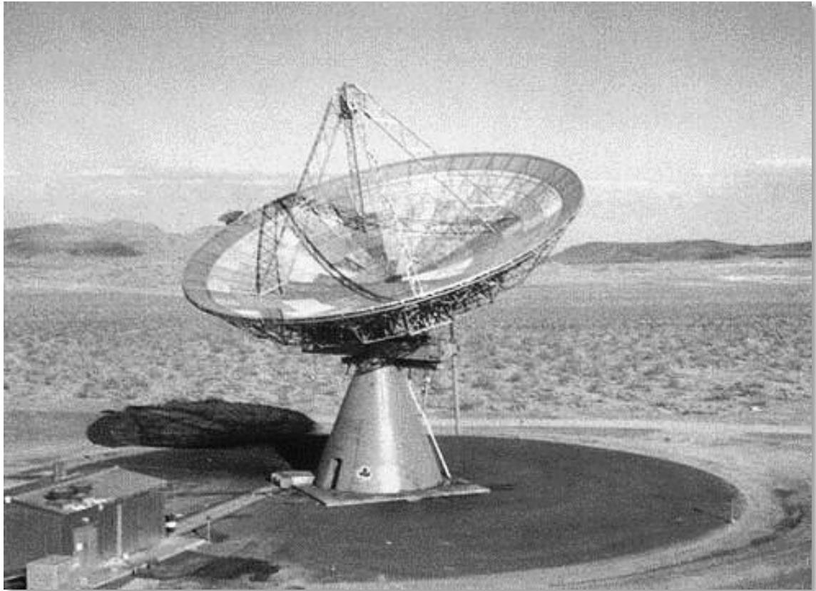
Fig.2 : L'antenne AZ-EL de 26 mètres de diamètre de la station de Goldstone du Jet Propulsion Laboratory qui était utilisée en couplage avec l'autre antenne HA-DEC pour détecter l'écho radar de Vénus en 1961.
