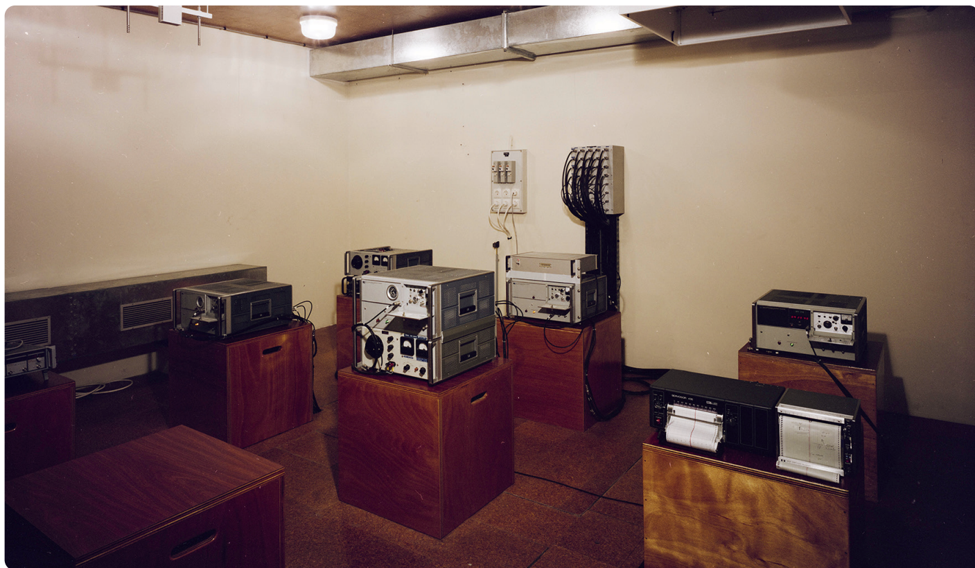
Salle des horloges atomiques au bâtiment B de l'Observatoire de Paris – juin 1984.
